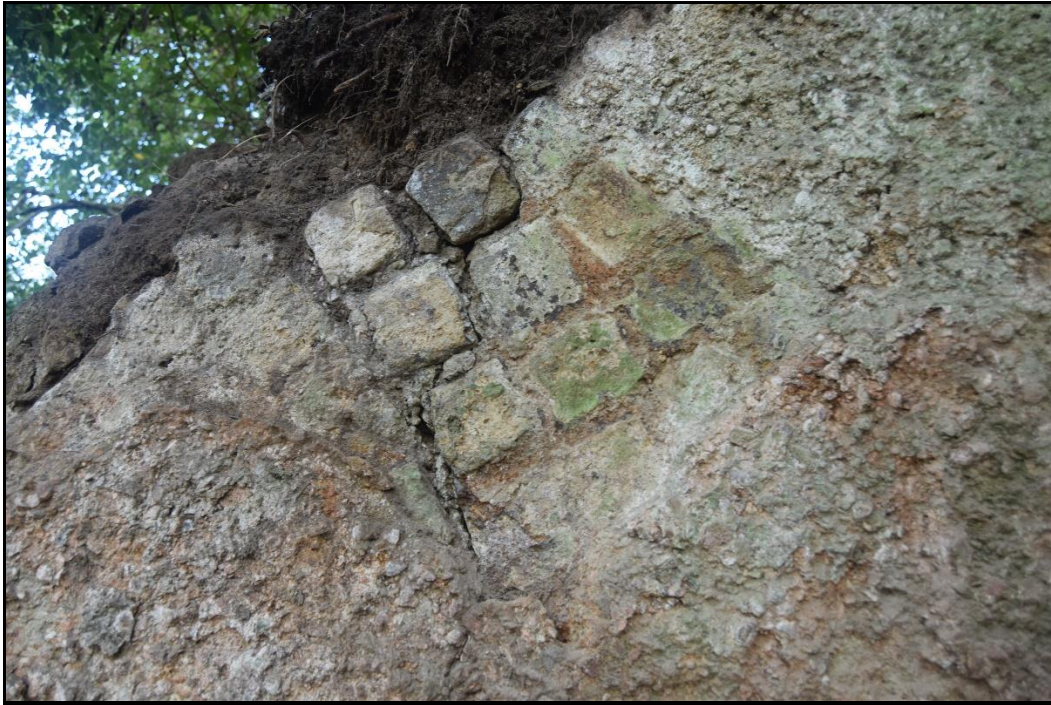
Fig. 8: particolare dell'opera quasi-reticolata visibile nella lacuna del rivestimento del paramento meridionale di USM12.
